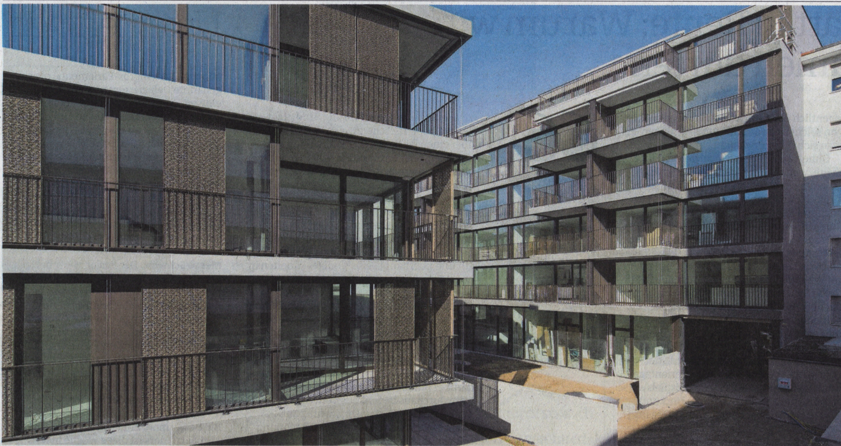
So geht Verdichtung: Auf einer Parzelle mit einem alten Haus entstanden drei Wohnhäuser mit 42 Eigentumswohnungen. (Basel, 2017)
