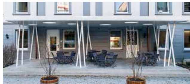
Mit den unregelmässig verteilten Stützen und den unsichtbaren Verbindungsteilen stellte das Vordach hohe Ansprüche an das Holzbau-Engineering
